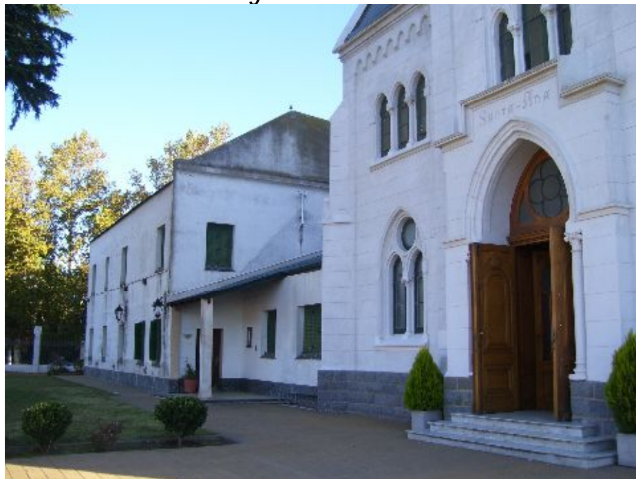
Frente Iglesia Santa Ana, y edificios auxiliares
